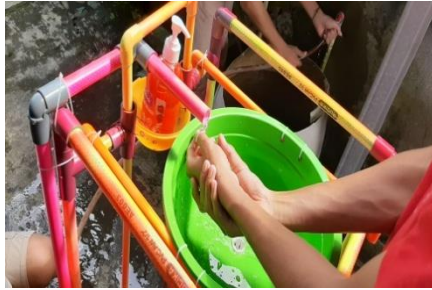
Gambar 7. Pemasangan tempat sabun
