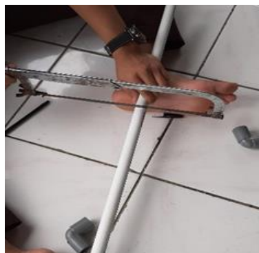
Gambar 3. Pemotongan Pipa
