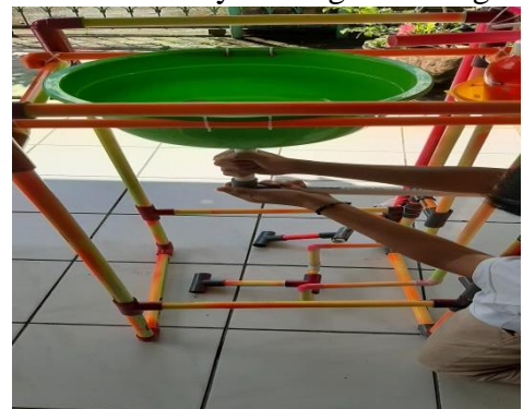
Gambar 6. Penyambungan ember sebagai wastafel
